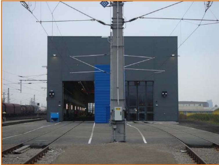
Die Abfangung im Torbereich ermöglicht eine raumsparende, klare und sichere Auslegung der Oberleitung.
